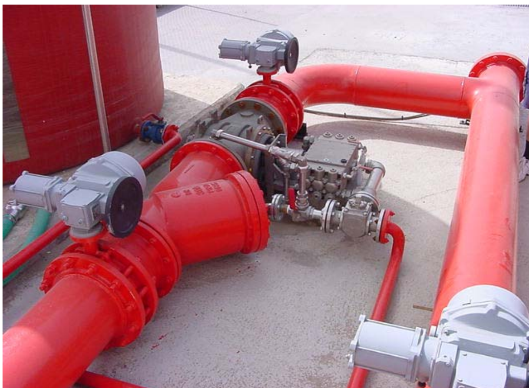
FD 10.000/3-PP-S versión en bronce para protección tanques hidrocarburos.
